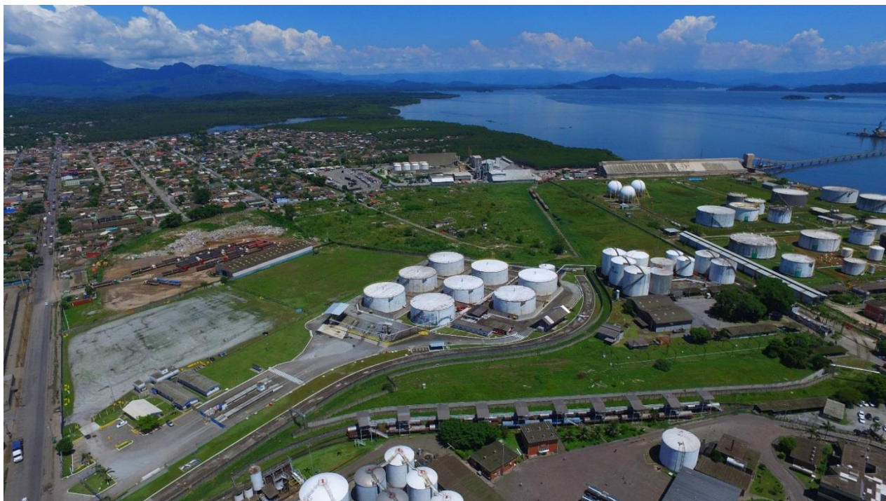
FOTO 51 – VISTA AÉREA DA ÁREA DO TERMINAL PÚBLICO DE ÁLCOOL DE PARANAGUÁ FOTO: TERIN
