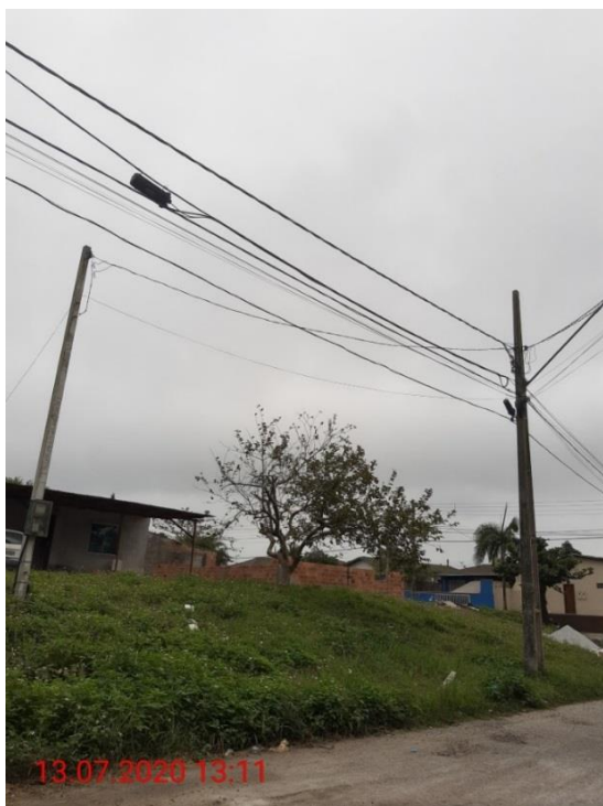
FOTO 40 – P21 – AVENIDA GOV MANOEL RIBAS. 1574 FOTO: JACKSON GOLDBACH
