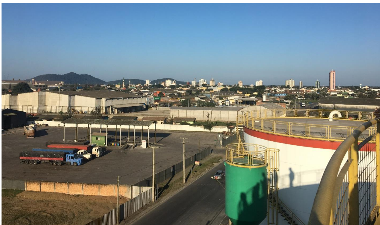
FOTO 52 – VISTA AÉREA DA ÁREA DE REQUALIFICAÇÃO URBANA FOTO: LUCIANA CARDON
