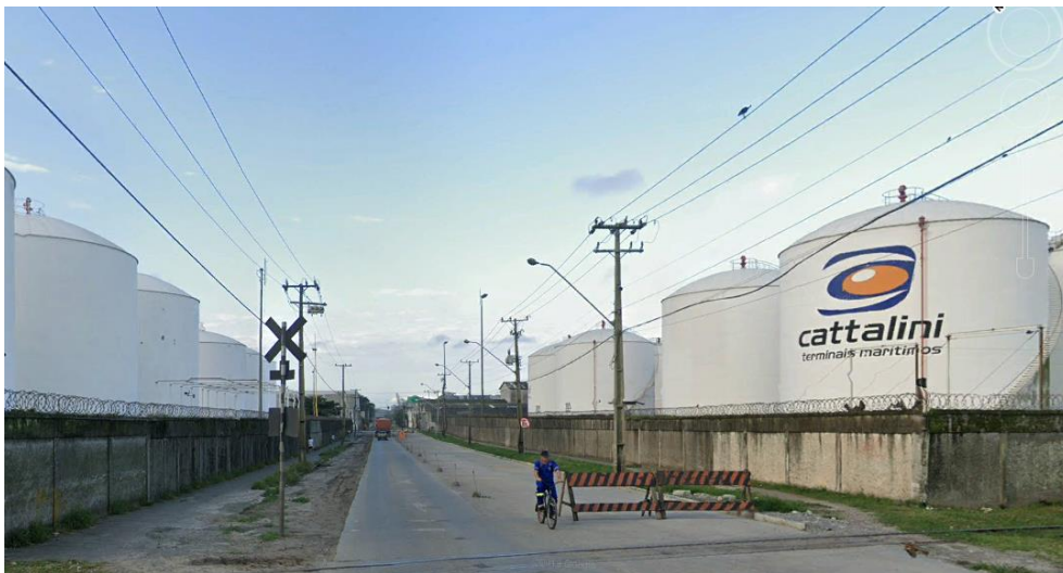
FOTO 85 – VISUALIZAÇÃO DE TANQUES DA EMPRESA CATTALINI FOTO: GOOGLE EARTH, 2020
