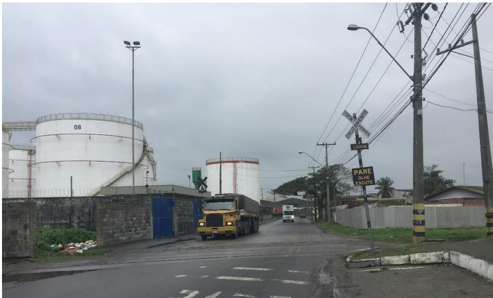
FOTO 83 – VISUALIZAÇÃO DE TANQUES DO TERMINAL DE GRANÉIS LÍQUIDOS DA TERIN FOTO: DANIEL MACEDO
