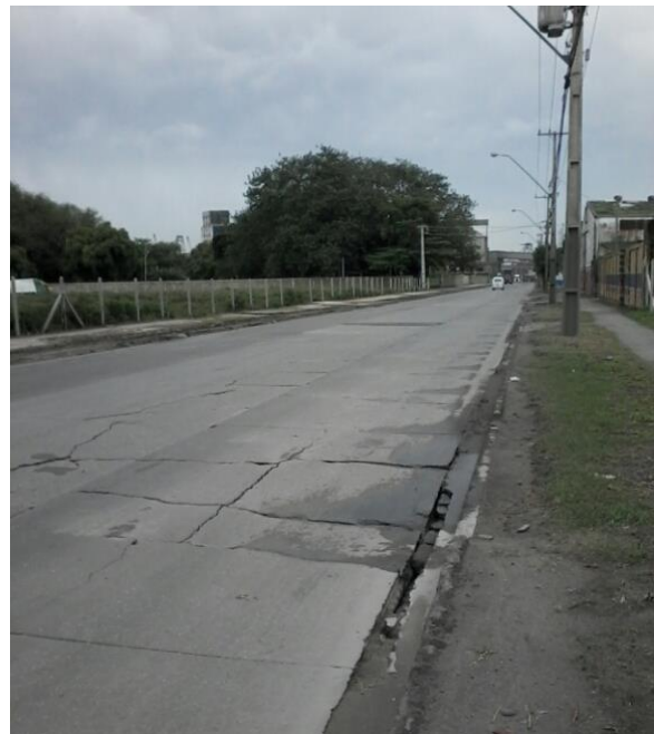
FOTO 77 - AV. BENTO ROCHA, SENTIDO LESTE FOTO: TIAGO OTTO MARTINS
