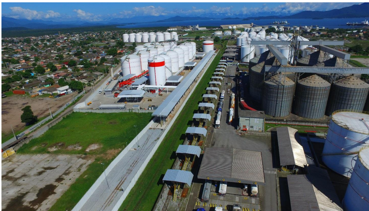
FOTO 47 – VISTA AÉREA PARCIAL DA ÁREA DO TERMINAL 2 FOTO: TERIN
